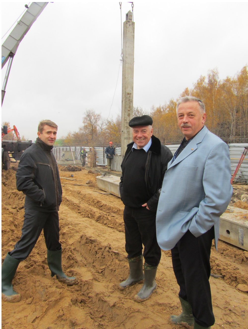
Строительство завода «Электропровод» в г. Подольск, слева направо: М.В. Дуйнов, В.Н. Милованов, Е.Б. Васильев
