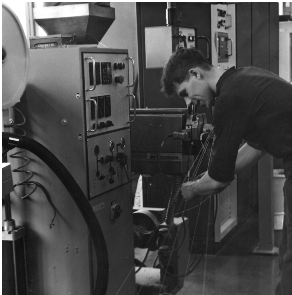
В новом цехе оптически кабелей. Фотография 1990 г.
