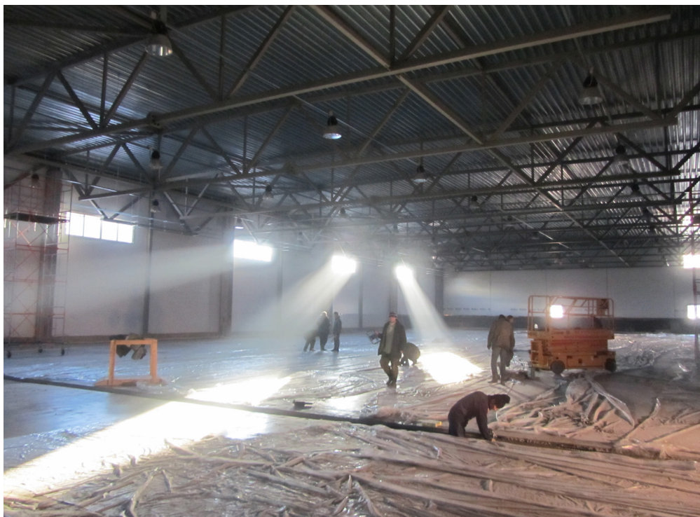
Заливка полов в новом цехе завода
