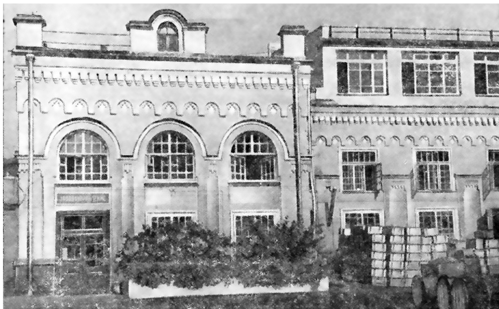
Вид левой части здания бывшего фабричного театра. Фото В. Кондрашова, 1965 г.
