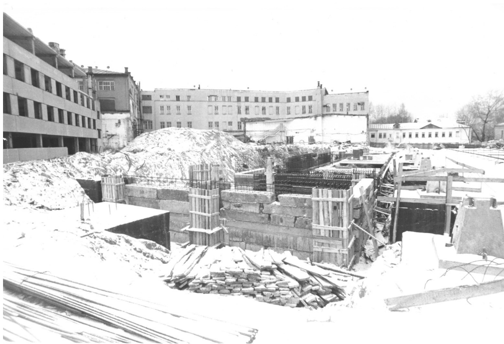
Закладка фундамента трёхэтажного корпуса оптических кабелей на Малой Коммунистической улице. Фотография 1988 г.
