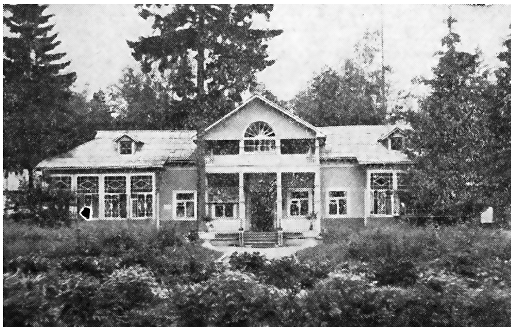
Здание столовой пионерского лагеря под Можайском. Фотография 50-х годов
