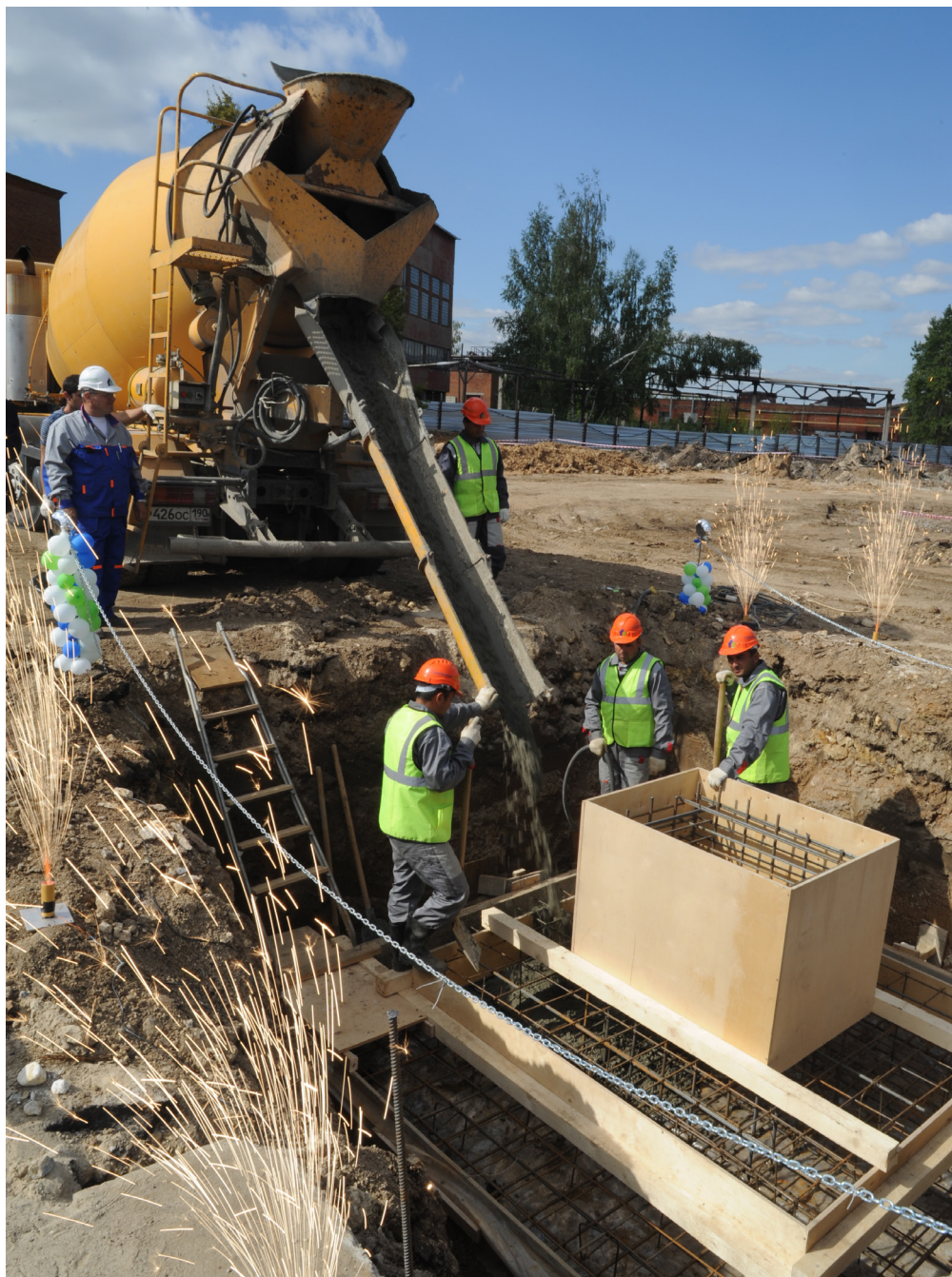
Закладка первой бетонной опоры для строительства нового корпуса завода «Электропровод». Фотография 2011 г.
