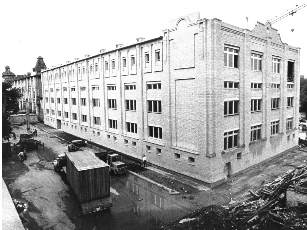
Новый административный корпус на Малой Коммунистической улице. Фотография 1987 г.
