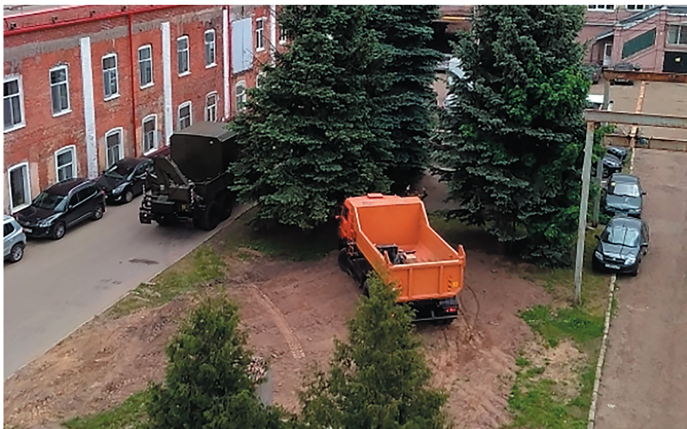
Слева главный корпус оптических кабелей и медных кабелей с изоляцией из кремнийорганической резины в г. Ивантеевка
