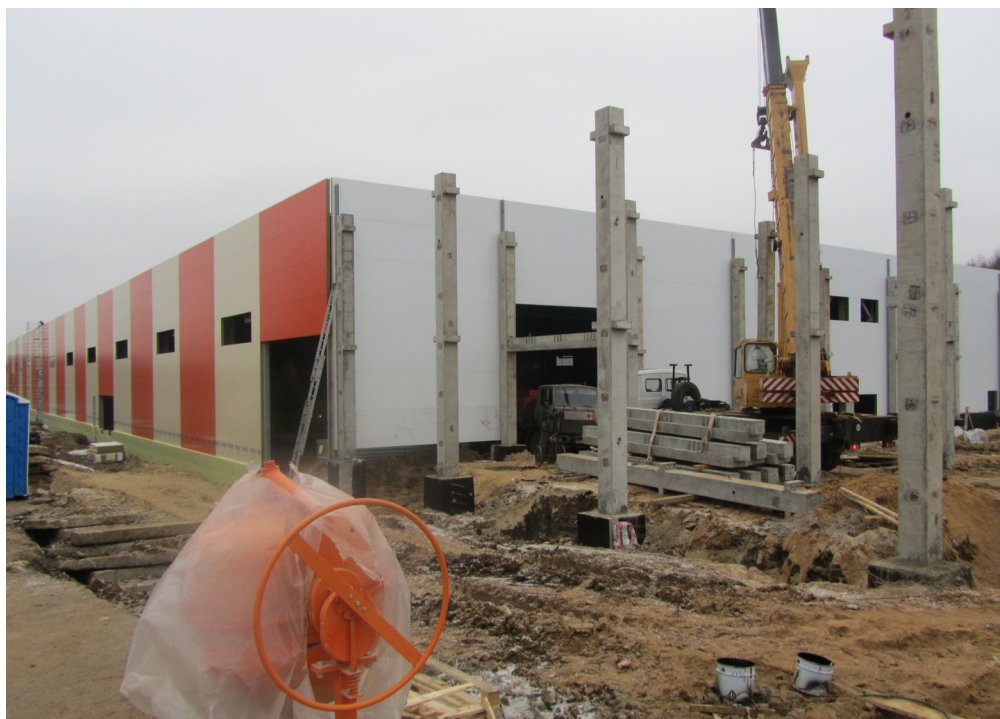
Строительно-монтажные работы нового производственного корпуса завода. Фотография 2012 г.
