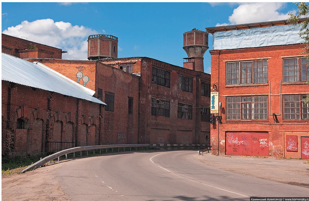
Слева корпус бронирования и изолирования оптических кабелей в г. Ивантеевка
