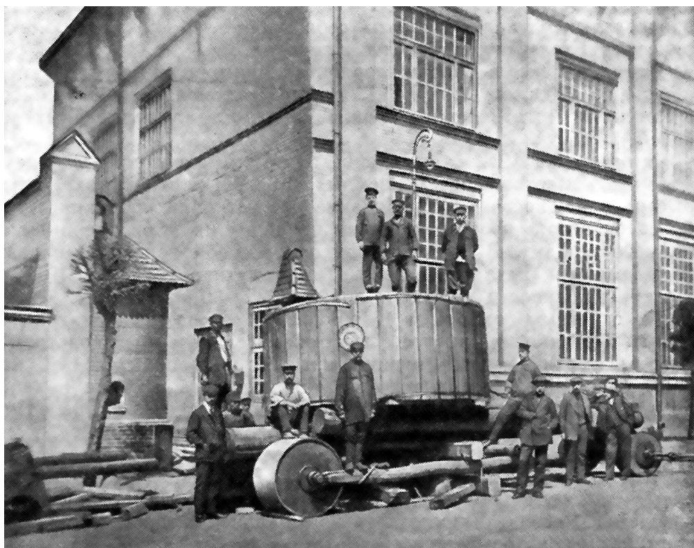
Погрузка и транспортировка крупного кабеля с завода. Фотография 1913-1914 гг.
